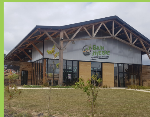
Un magasin sous une charpente agricole à Chantepie (35)
